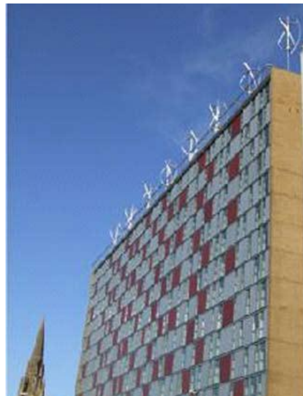
QuietRevolution vindturbiner på leilighetskompleks London Road. Kilde: www.quietrevolution.co.uk
