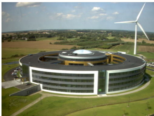
Widex Byggeri, Lyngby, kontorbygg, Danmark
