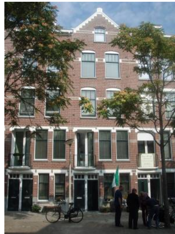
Verneverdig boligblokk i Rotterdam Sleephelling, rehabilitert til passivhusstandard. Kilde: SINTEF Byggforsk
