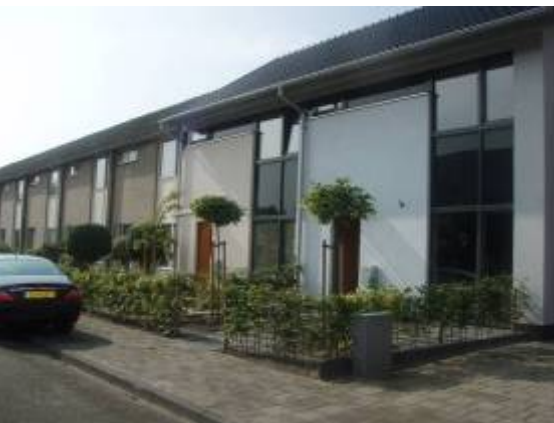
Passivhus i Roosendaal i Nederland Rehabilitering av borettslag. Kilde: SINTEF Byggforsk
