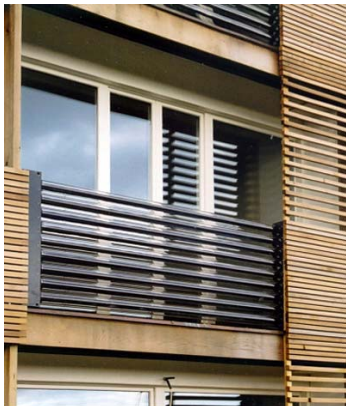
Vakuumsolfangere i rekkverk. Boligblokk ved Zürich. Kilde: Robert Hastings
