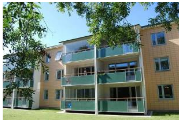
Passivhus i Alingsås, Sverige. Rehabilitering av 300 leiligheter. Kilde: www.passivhuscentrum.se
