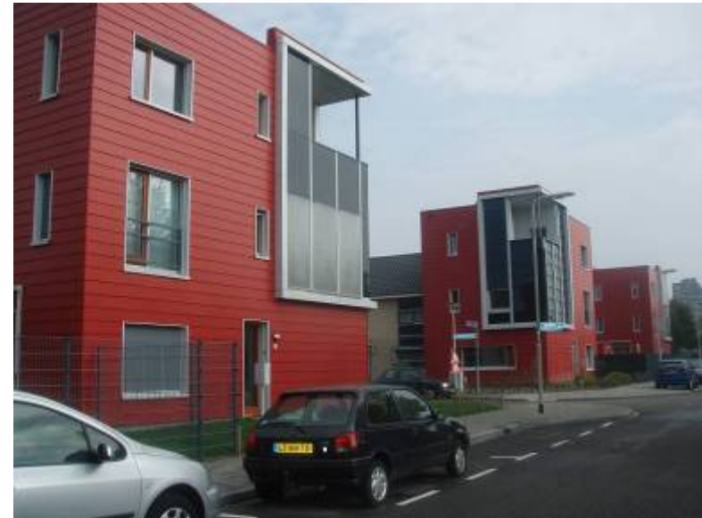
Vannsolfangere (hus nærmest) og solceller (hus nr. 2) i fasader i passivhus i Roosendal i Nederland. Kilde: SINTEF Byggforsk
